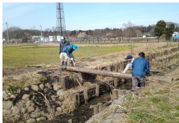
丸太橋の修繕作業
